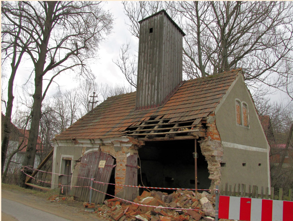
Das stark beschädigte Feuerwehrhaus in Süßenbach / Bełczyna am 11.03.2017
